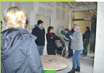
Birgit Strauß, Leitung der Frühförderstelle, beantwortet Fragen der Besucher bei der Baustellenbesichtigung.
