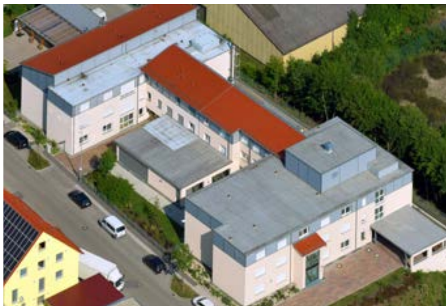
Die Wohnheime 1 und 2 in der Henry-Dunant-Straße in Ansbach aus der Vogelperspektive, rechts befindet sich der Neubau aus dem Jahr 2012
